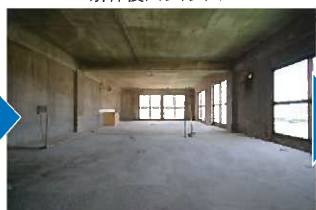
解体後スケルトン
