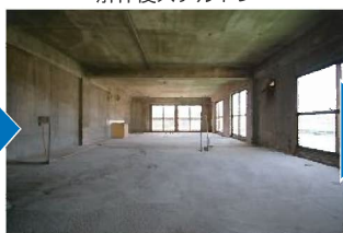
解体後スケルトン
