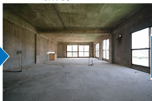
解体後スケルトン
