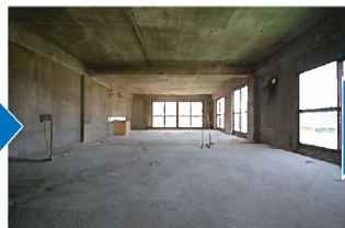
解体後スケルトン
