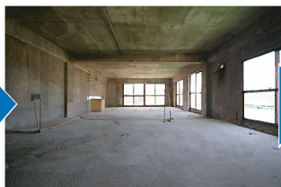
解体後スケルトン
