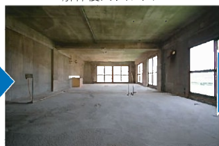
解体後スケルトン
