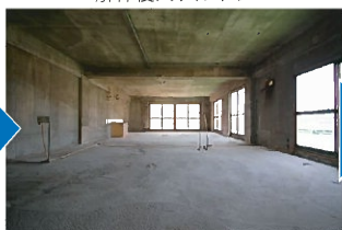
解体後スケルトン
