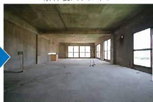
解体後スケルトン
