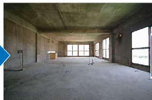
解体後スケルトン
