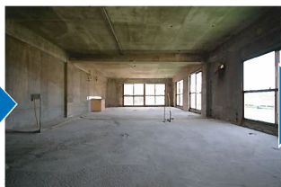
解体後スケルトン
