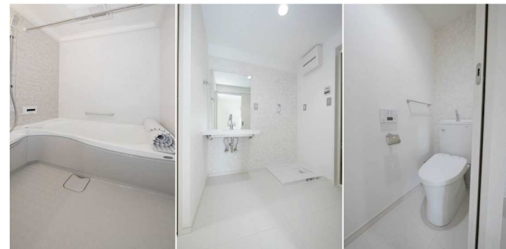
スケルトンの状態から創り上げているので水廻りはすべて最新設備です
