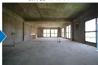
解体後スケルトン
