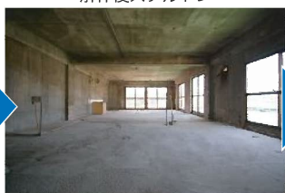
解体後スケルトン
