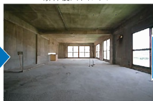
解体後スケルトン
