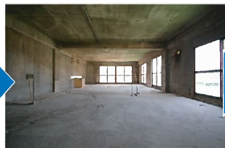
解体後スケルトン
