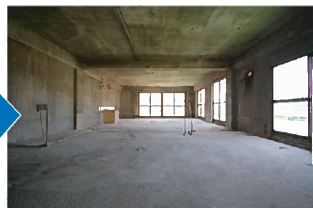
解体後スケルトン
