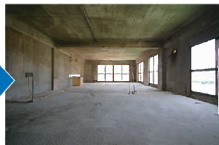
解体後スケルトン
