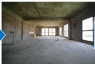
解体後スケルトン
