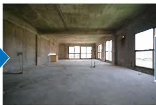
解体後スケルトン
